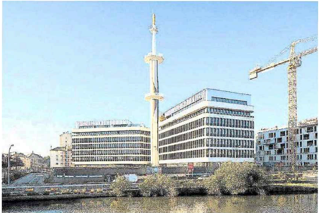
La fonction du centre des télécommunications exigeait la construction d'une antenne hertzienne de 83 mètres à laquelle l'architecte ajouta une plateforme de contrôle à 60 m de haut, qui prit alors la forme d'une soucoupe volante.
